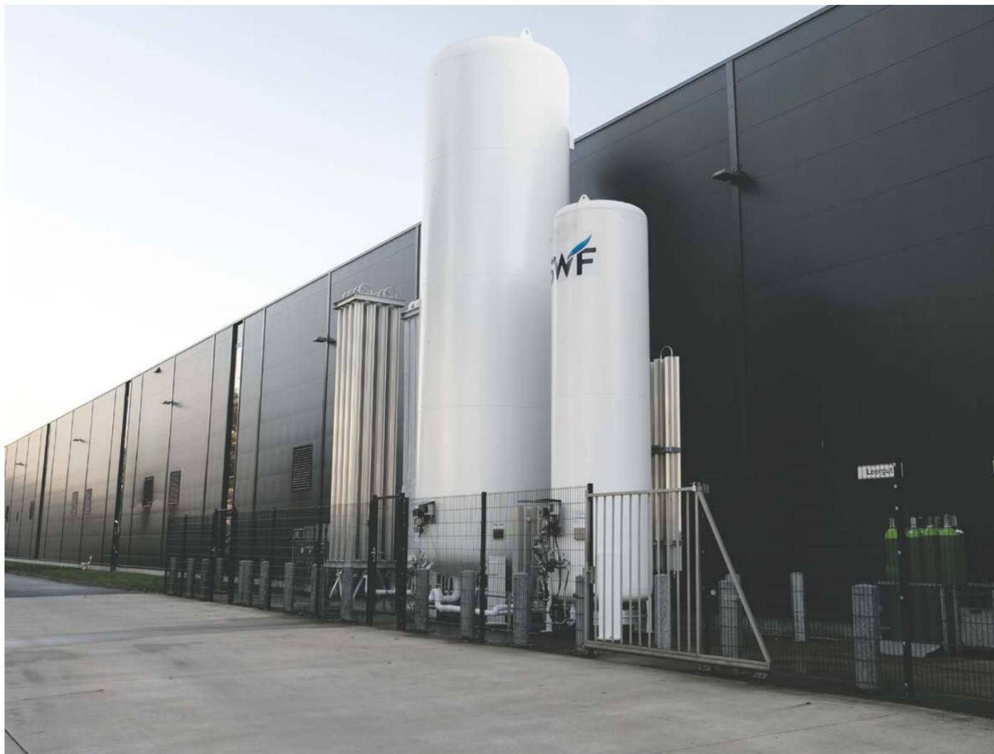
Neu aufgestellte Tankanlage für die Versorgung der Laser mit Stickstoff 5.0 flüssig und Sauerstoff Lasertech flüssig.
