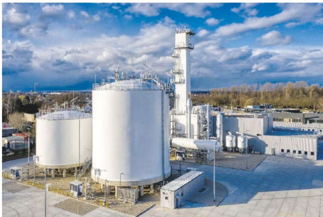
Luftzerlegungsanlage Werk Bielefeld: Umgebungsluft wird eingesogen, gereinigt und so tief herabgekühlt, dass sie sich in deren Bestandteile Argon, Sauerstoff und Stickstoff verflüssigt und separiert werden kann.
